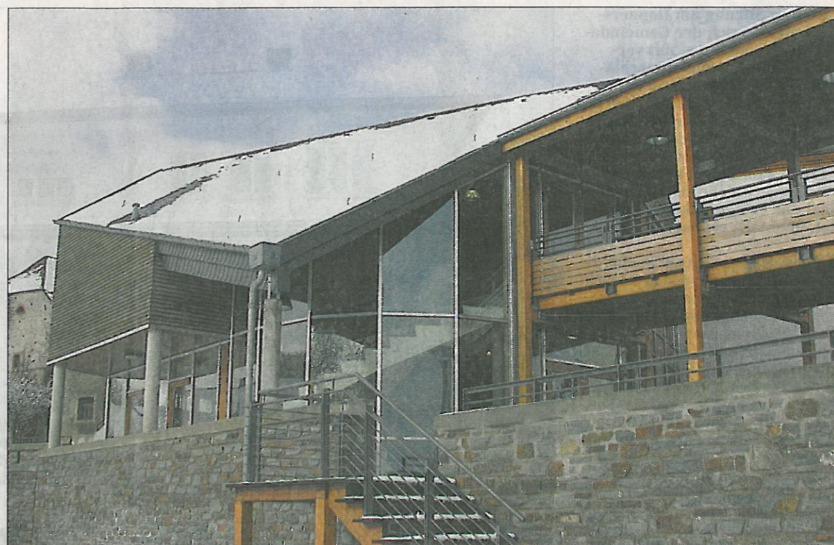
Das „Haus der Kultur“ ist mit dem Gesicht zum Licht gebaut. Wenn die Sonne im Süden ihren Lauf nimmt, hat sie die großzügigen Glasfronten im Visier. (Photos: Nico Müller)
